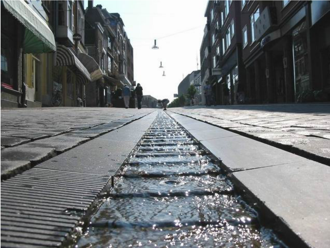
Figuur 1. De regenwatergoot in de Stikke Hezelstraat te Nijmegen. Bij droog weer wordt water teruggepompt, zodat het blijft stromen.
