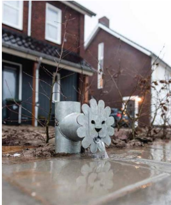
Figuur 4.3. De leeuwse waterspuwer. De waterdruk vanuit de dakgoten zorgt voor de afvoer van regenwater (bron: Egbert-Jan Lam BuroJET )
