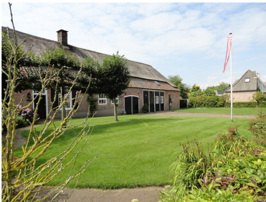
Figuur 8.1. Oude boerderijen in het centrum van Liempde hebben vaak helemaal geen dakgoot.
