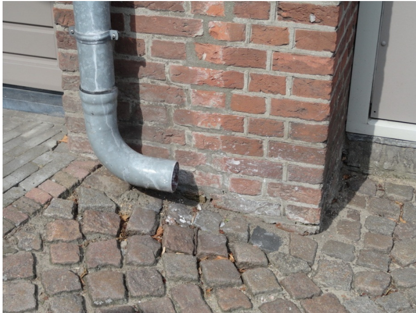
Figuur 6.2. Het water vanuit de dakgoten van de oudere panden in Liempde gaat vaak niet direct naar de riolering.
