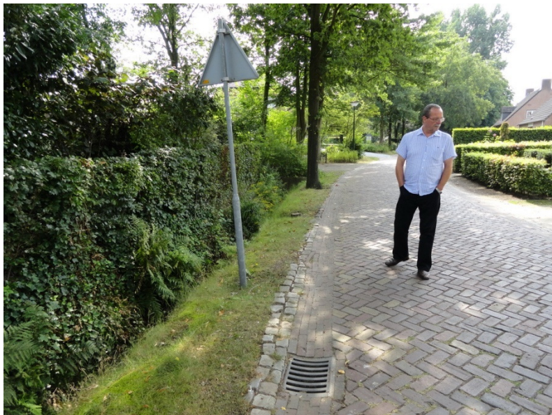
Figuur 6.1. Vanaf de straat kan het regenwater zo de greppel instromen. Toch wordt het nog via de put afgevoerd naar de riolering.
