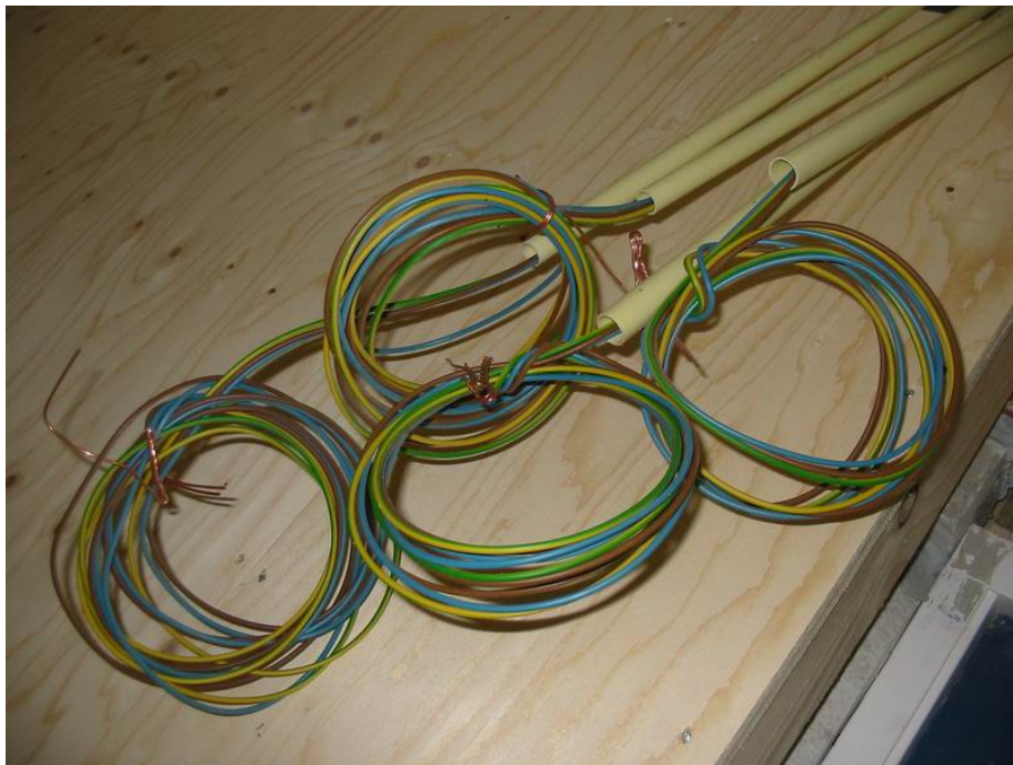
Figuur 5.1. Detail van een verbouwing in Bathmen. De installateur trekt nieuwe leidingen voor de elektriciteit.
