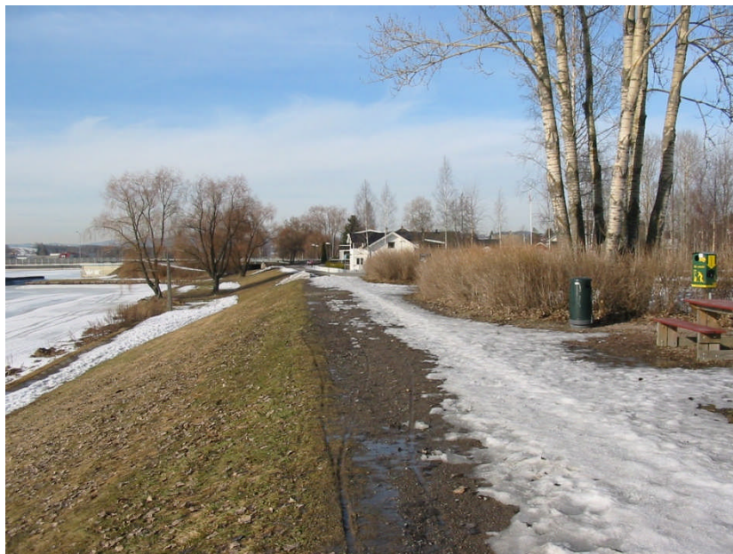
Figuur 3. Ontkenning van complexiteit resulteert vaak in ongewenste compromissen. Hier een dijk in Lillestrøm waarvan de kruin ter plaatse van woningen met uitzicht iets omlaag is gebracht.
