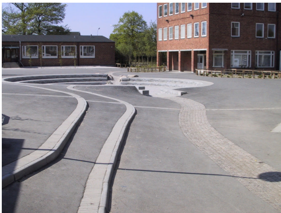
Figuur 3. Een amfitheater in een schoolplein te Malmö; een idee van de leerlingen zelf. Als het hard regent, wordt regenwater hier geborgen (foto: Peter Stahre).
