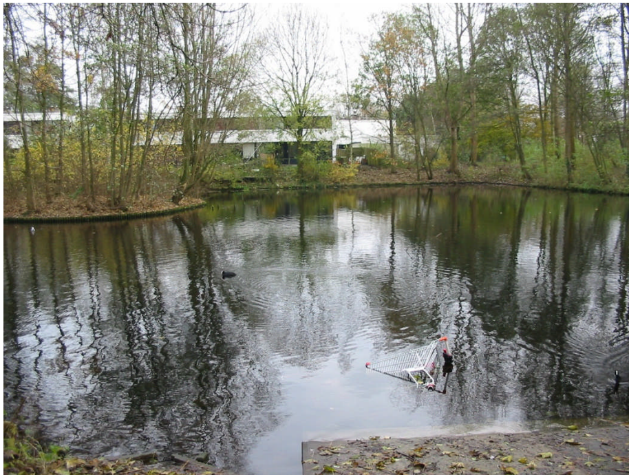
Figuur 1. Vijver in een woonwijk uit de jaren ‘70. Formeel is dit geen vijver, maar een interne overstort van het gemengde rioolstelsel. Water werd toentertijd puur functioneel ontworpen.
