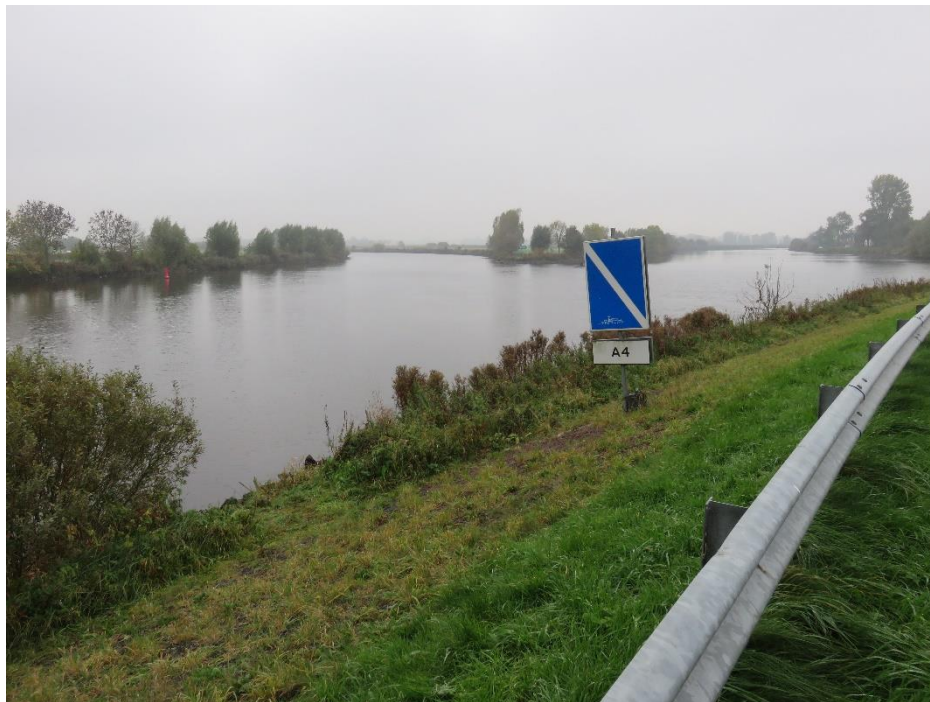
Figuur 19 Het tweede dijkvak bevindt zich waar de Vecht in het Zwarte Water stroomt.
