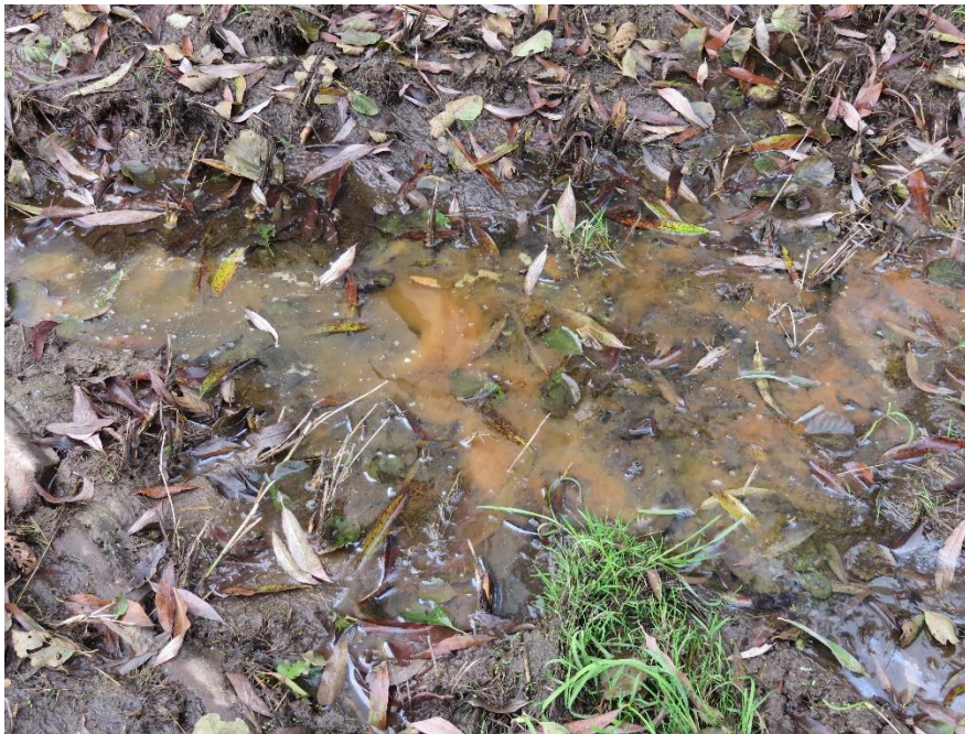
Figuur 14 Water dat uit het dijklichaam sijpelt, bij de binnenteen.
