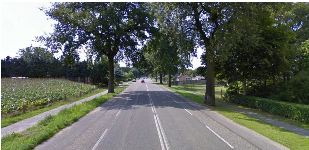
Figuur 16 De Graafsebaan. De weg is overgedimensioneerd.
