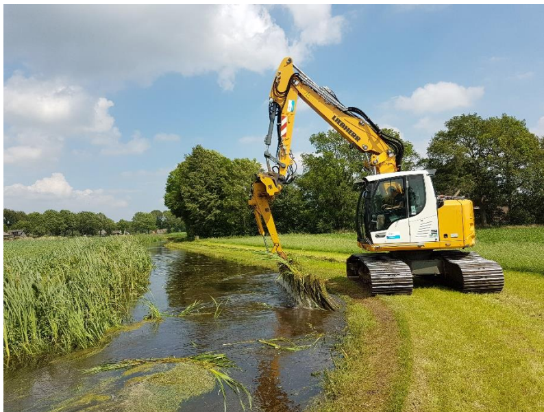
Figuur 3. Het deels verwijderen van beplanting in een waterloop (juni 2019) ten behoeve van de aanvoer van water.
